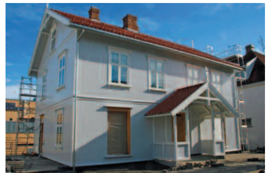
Rosendal rett før gjenoppbyggingen er ferdig.
