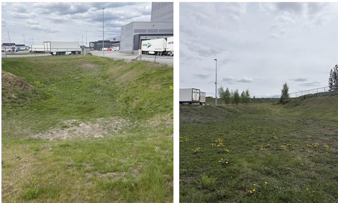
Figur 3-7. Bilder fra befaring som viser åpne fordrøynings- og infiltrasjonsareal på eiendommen.
