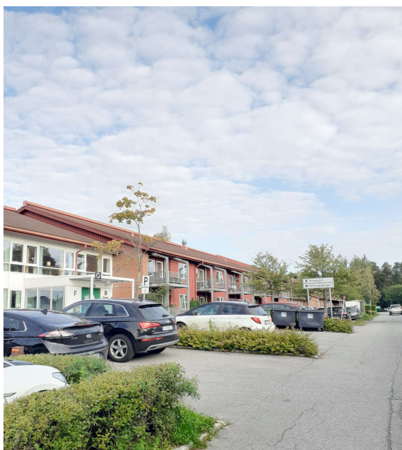
Omsorgsleilighetene sett fra syd mot inngang
