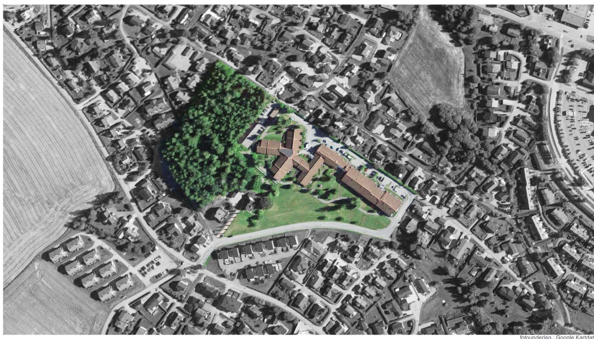
Eksisterende anlegg sett ovenfra.
