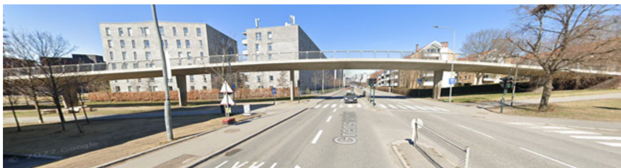
Figur 2.6.5 - Foto av gs-veg på bro over Grenseveien på Ensjo, Oslo. Kilde: Google Maps.
