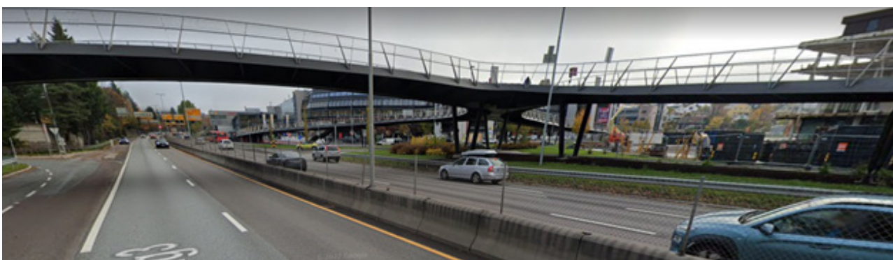
Figur 2.6.3 - Foto med gs-veg på bro med ramper over Ring 3 ved Ullevål stadion, Oslo. Kilde: Google Maps.
