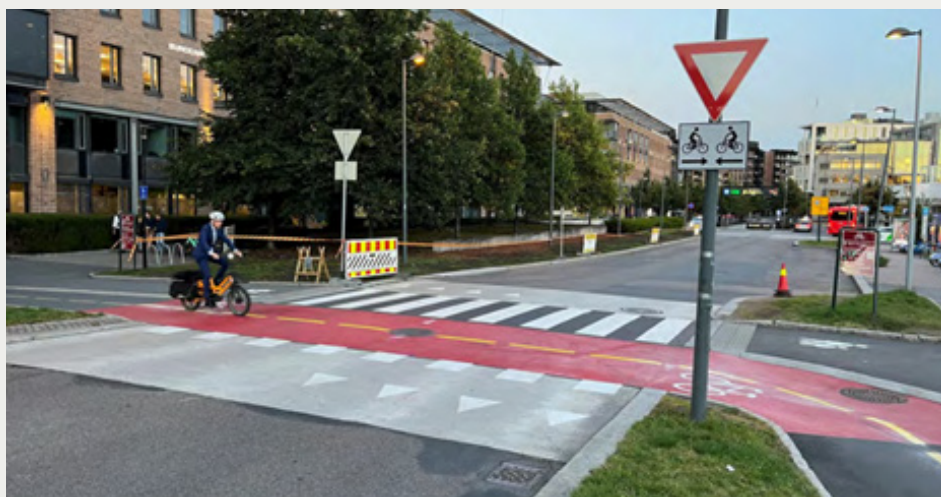
Figur 1.5.1 – Foto av forkjøringsregulert sykkelveg ved Filipstadveien mot Tjuvholmen (Asplan Viak, 2022).
