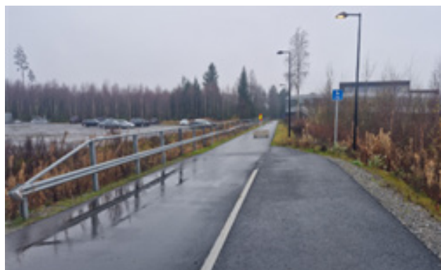
Figur 2.5.3 - Foto av eksisterende gs-veg langs bekk vestover mot Jessheimbadet.
